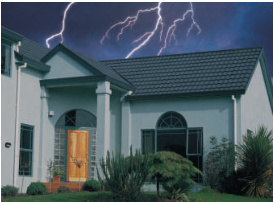
Acoperișurile metalice nu sunt mai expuse la fulgere decât cele nemetalice
